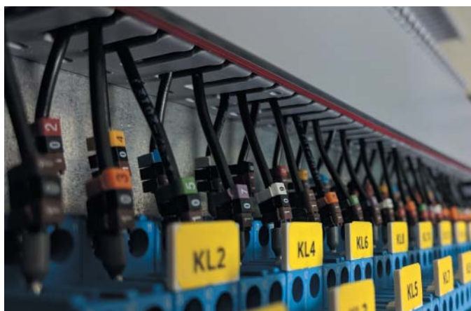
▲ Рис. 2. Перфорированные короба и система маркировки “Quadro”
