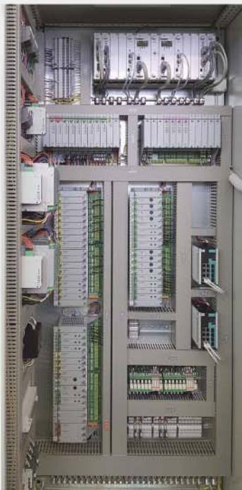
В шкафах УСО на базе Многофункционального контроллера связи с объектом (МКСО) нет необходимости в установке большого количества дополнительных устройств (таких как объектовые и промежуточные клеммники, промежуточные реле, барьеры искрозащиты, устройства защиты от импульсных перенапряжений, преобразователи и разветвители сигналов, предохранители, размыкатели и др.).
