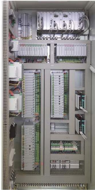
В шкафах УСО на базе Многофункционального Контроллера Связи с Объектом (МКСО) нет необходимости в применении большого количества дополнительных устройств (таких как объектовые и промежуточные клеммники, промежуточные реле, барьеры искрозащиты, устройства защиты от импульсных перенапряжений, преобразователи и разветвители сигналов, предохранители, размыкатели и др.).
