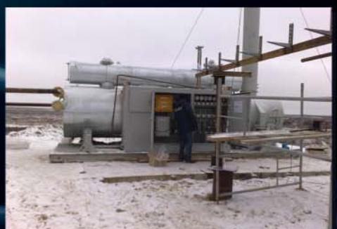
Оборудование, выполненное на базе комплекса ДЕКОНТ-Ex, позволяет осуществлять обмен информацией с АСУ ТП верхнего уровня, используя различные каналы связи - радиоканал, GSM, передача данных по силовому кабелю, интерфейс RS-485 и др.
