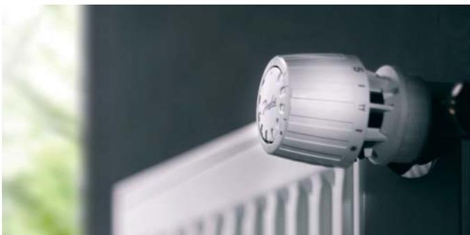
Рис. 1. Автоматический радиаторный терморегулятор
